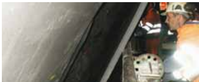
Spezialist für Tunnelisolierung von NMC Termonova Oy. Un spécialiste de l'isolation des tunnels de chez NMC Termonova Oy. Tunnel insulation specialist from NMC Termonova Oy.
