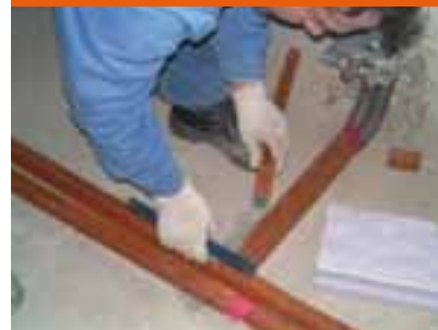
Anschlussstücke werden leicht nachisoliert. Les raccords s'isolent facilement une fois confectionnés. Subsequent insulation of joints is no problem.
